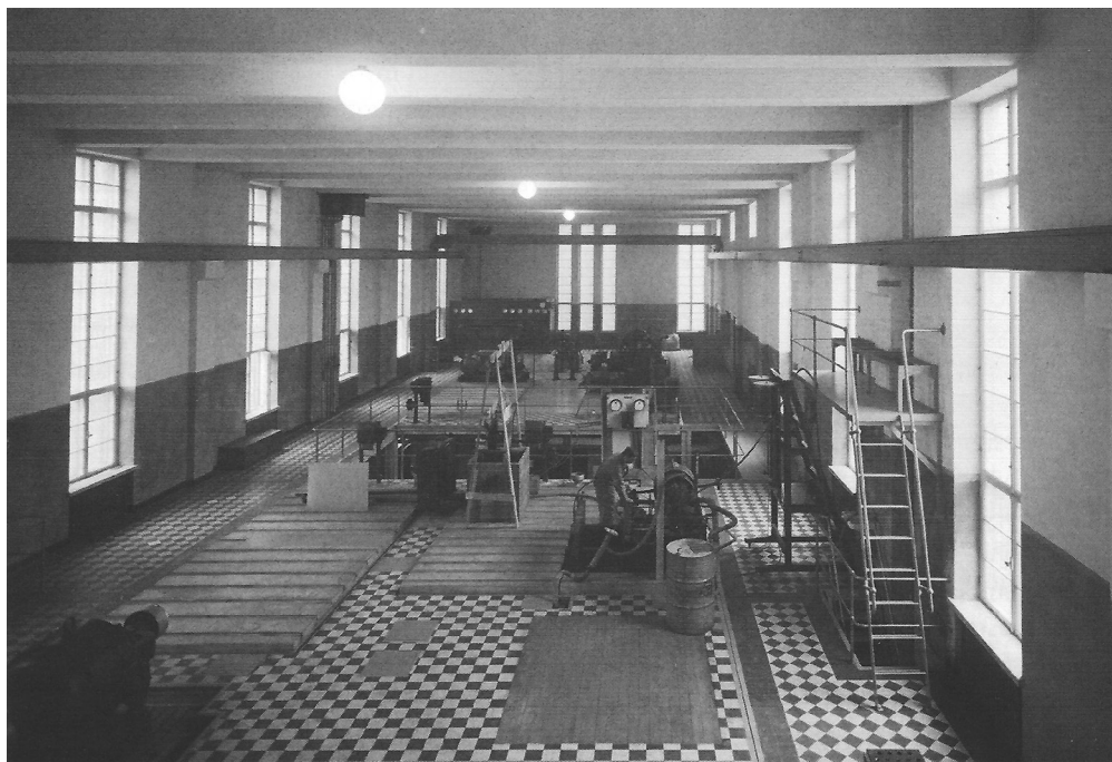
Kuva 68. Lämpövoimalaboratorion konehalli. (Nykänen 2007a, 213.)
