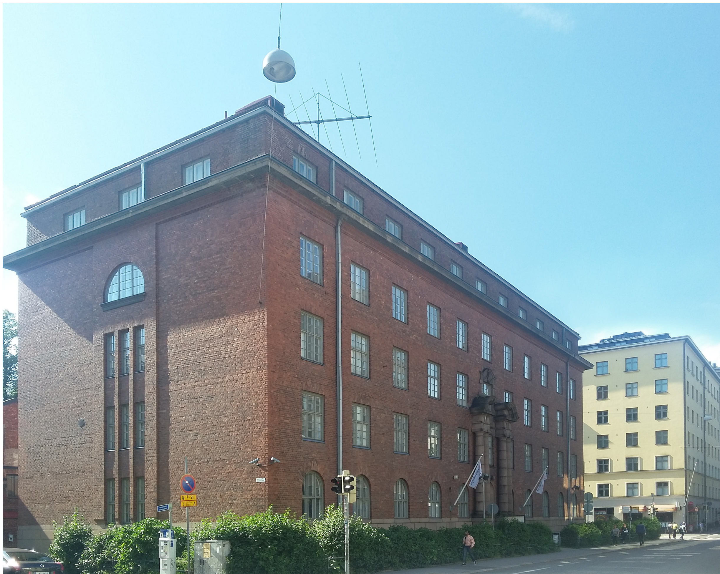
Kuva 73. Sähkölaboratorio Alber- tinkadun ja Kalevankadun kulmasta nähtynä 2015.
