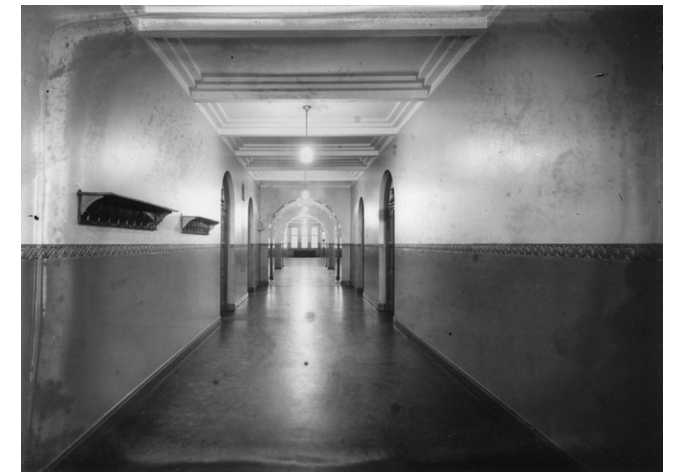
Kuva 66. Sähkölaboratorion käytävää. (HKM.)
